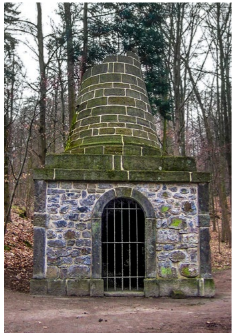
„Vergils Grab“ im Bergpark Wilhelmshöhe, Kassel
